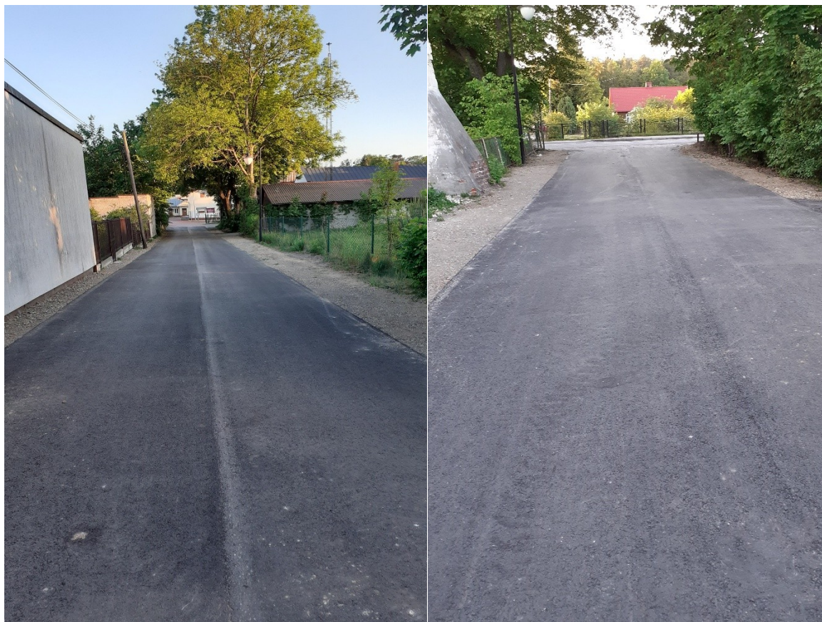
Remont drogi gminnej nr 110796L (ul. Szczepankiewicza) w Zwierzyńcu
