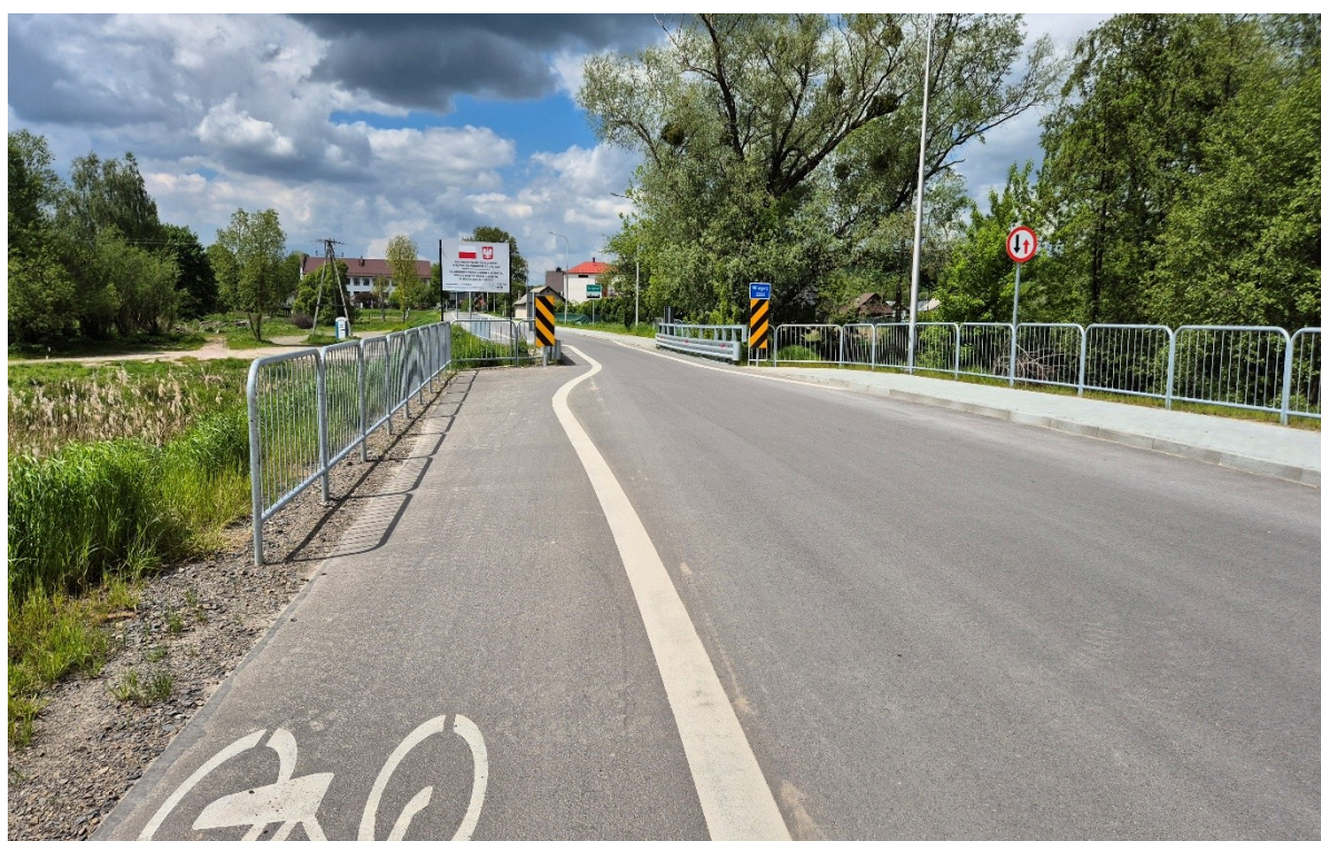
Przebudowa drogi gminnej nr 110776L wraz z oświetleniem ulicznym w miejscowości Bagno
