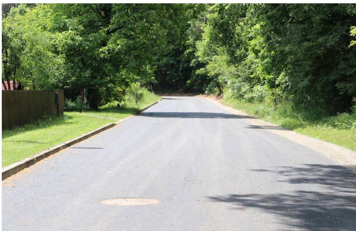
Remont drogi gminnej nr 110781L w miejscowości Obrocz
