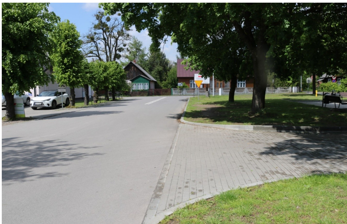
Remont drogi gminnej nr 110819L (ul. Rynek) w Zwierzyńcu
