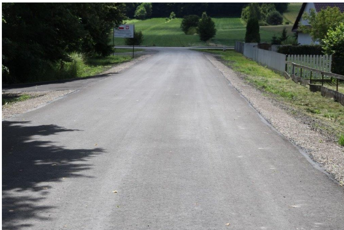
Przebudowa drogi gminnej nr 110783L w miejscowości Kosobudy
