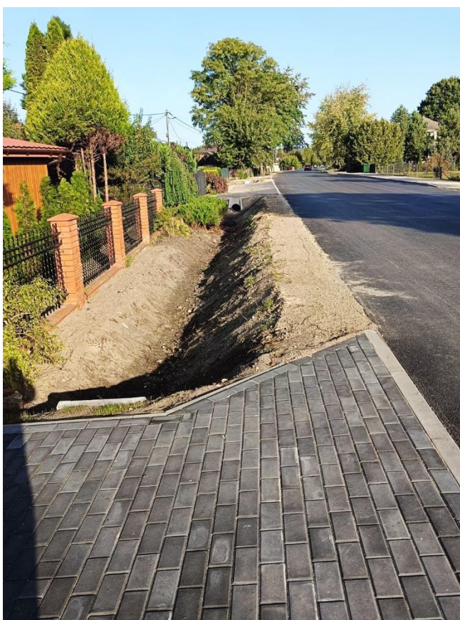
Przebudowana droga w Bagnie
