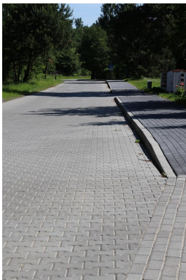
Budowa dróg gminnych ul. Nadrzecznej, ul. Józwiakowskiego, ul. Derlatki
